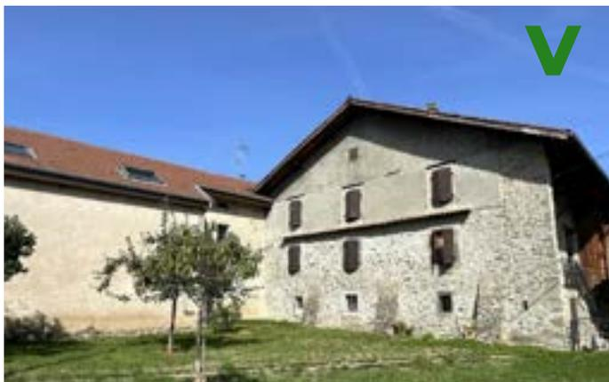
Loyer d'en bas. Exemple de bâti avec percements axés, volets bois et des barreaux au rez-de-chaussé pour sécuriser .
