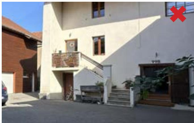
Bons-en-Chablais. Escalier d'origine modifiée avec mise en œuvre d'un garde-corps et création de pilastre de balustrade.
