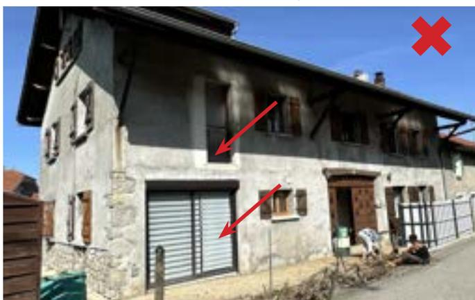
Loyer d'en bas. Dépose de l'allégé pour créer une porte fenêtre au R+1 et agrandissement de la baie du RDC avec volet roulant.
