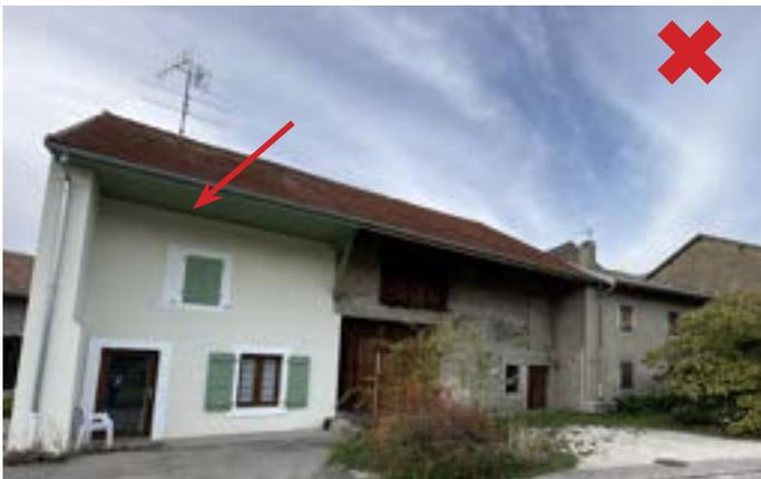
Brens. Forget de toiture formant plafond qui cache l'avant-toit. On note la différence entre la partie droite et gauche.
