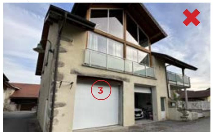
Brens. L'ancienne porte a été modifiée avec la création d'une fenêtre en bandeau et une allège pleine (1). Une nouvelle porte de garage a été percée (2) et une porte de grange a été transformée en porte de garage basculante (3).
