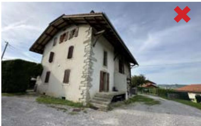
Langin. Chaînage d'angle avec enduit en sur-épaisseur
