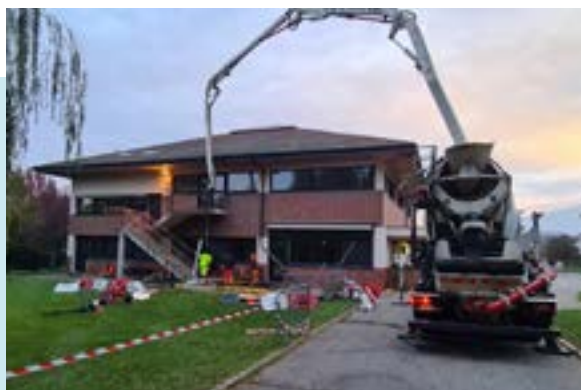
Installation d'un ascenseur à l'école
