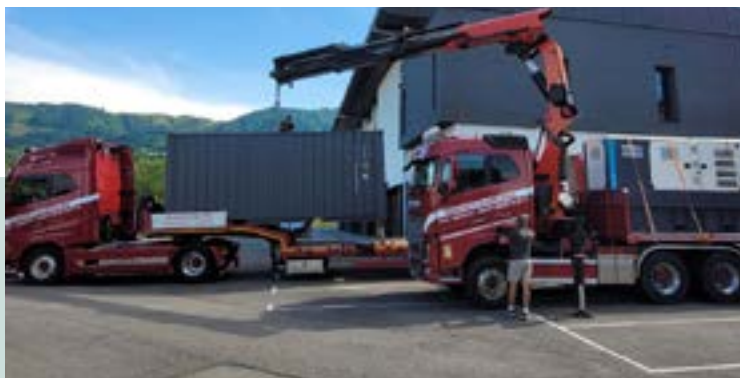
Pose des containers pour associations
