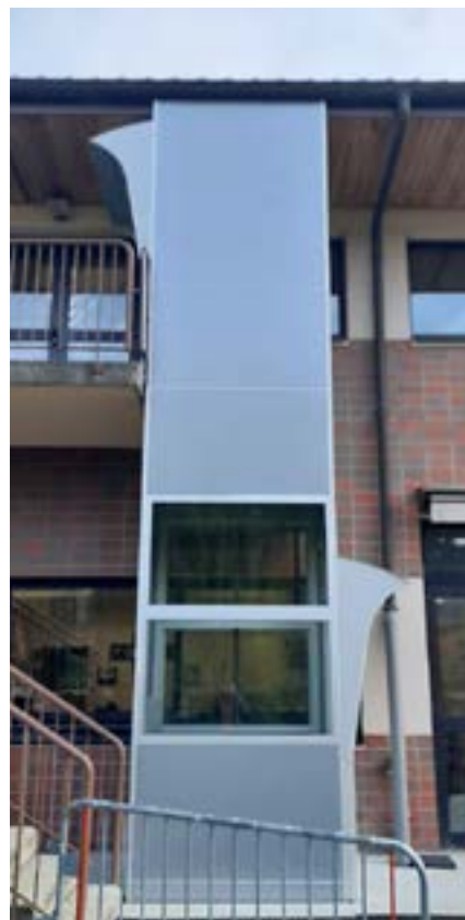
Pose de l'ascenseur école pour PMR
